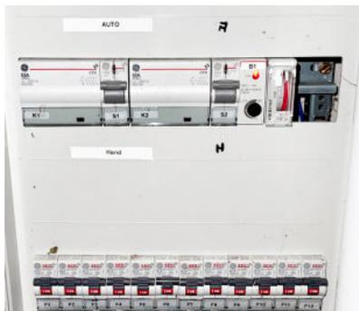
Der Schaltschrank der Straßenbeleuchtung in Barsikow. Rechts oben eine Zeitschaltuhr und links davon ein Schalter der auf Lichtintensität schaltet
