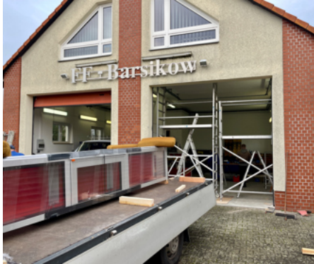
Entfernung des bestehenden Tores
